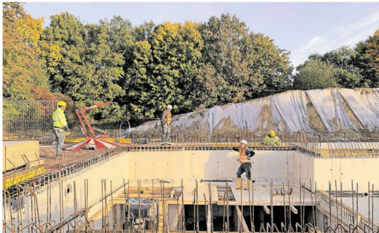
Recht reges Treiben herrscht auf der Baustelle an der Roermonder Straße.
